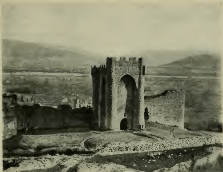
Ruines du château de Cruas
